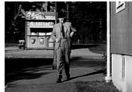
Kiosken vid Skördevägen 1939, där idag en Thaiservering finns
